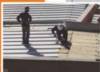
Proceso de Construcción.
