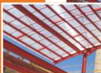
Proceso de Construcción.
