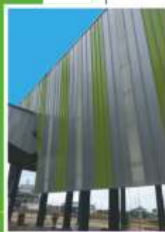
Proceso de Construcción.
