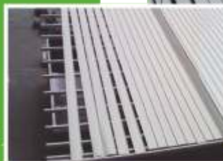
Proceso de Construcción.
