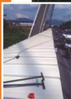
Proceso de Construcción.
