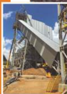
Proceso de Construcción.
