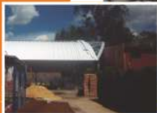
Proceso de Construcción.
